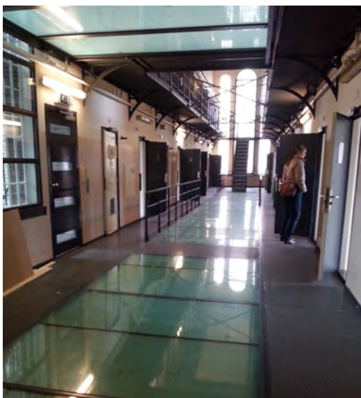
Galerij aan de dwars as, voorzien van semitransparante vloer, foto Rijksvastgoedbedrijf
