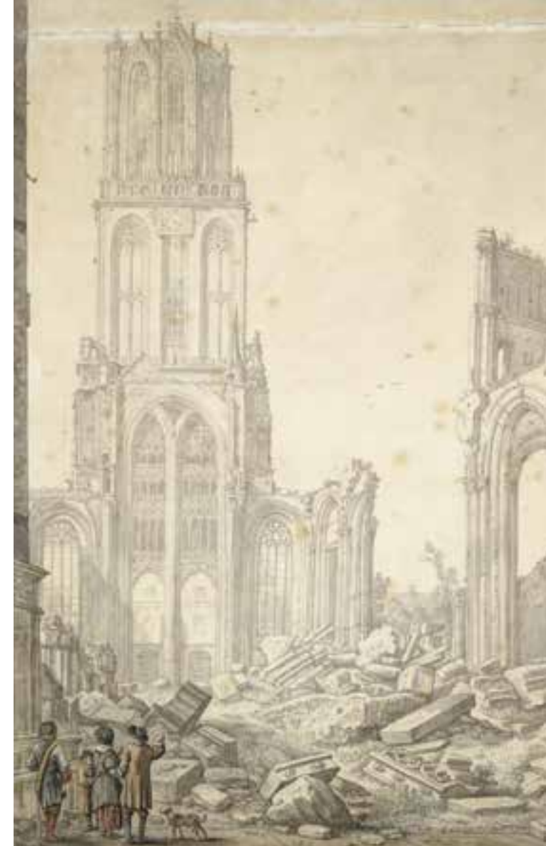
▲ Na het instorten van een deel van het schip van de Domkerk door een verwoestende storm in 1674, bleef het puin nog anderhalve eeuw liggen. De resterende kerk werd dichtgemetseld en gerepareerd en restanten werden stukje bij beetje hergebruikt in andere bouwwerken.
