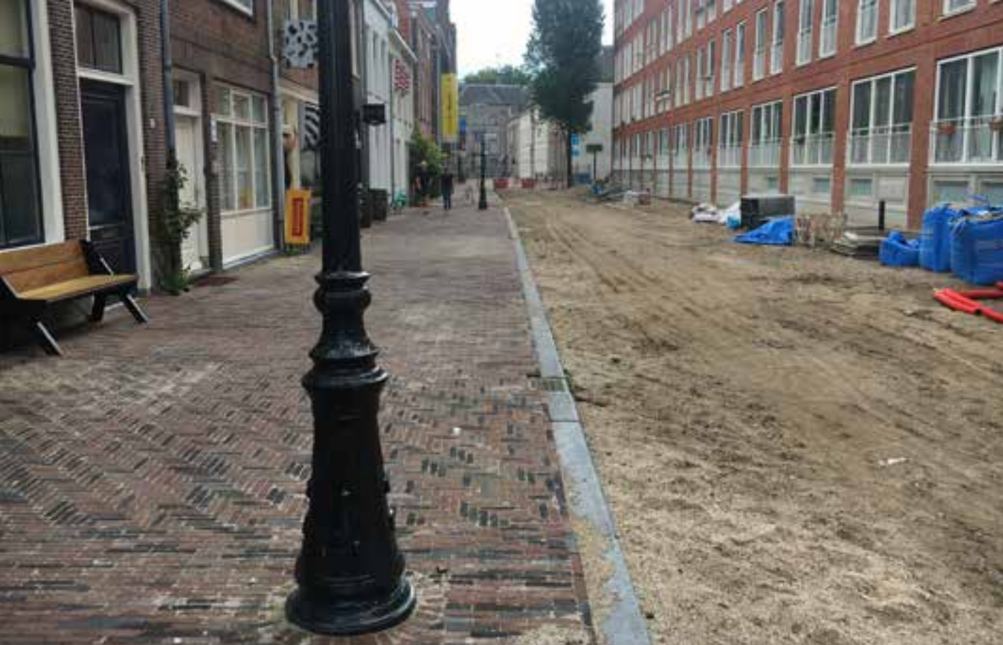
▲ Nieuwe bestrating in de Lange Nieuwstraat.
